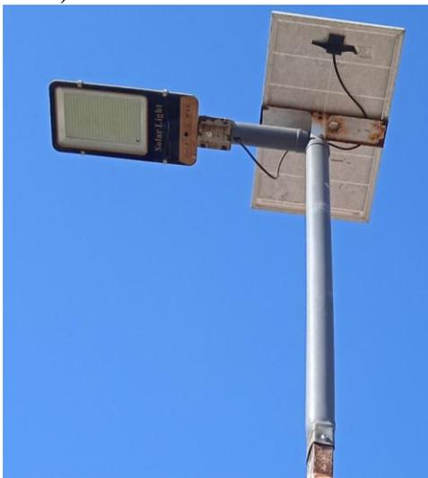
Gambar 8 Penyanggah PLTS penerangan setelah diganti dengan bahan PVC
