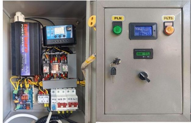
Gambar 11. Komponen rangkaian inverter, SCC dalam panel Box
